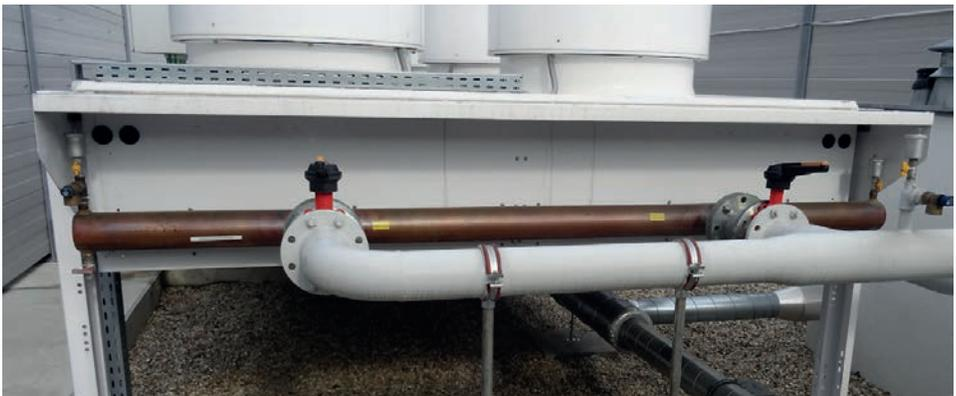
Abbildung Blick auf Rückkühleranschluss mit Luftdüsen
