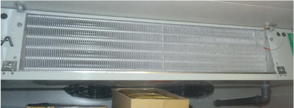
Abb. Blick auf Verdampfer in einer Kühlzelle
