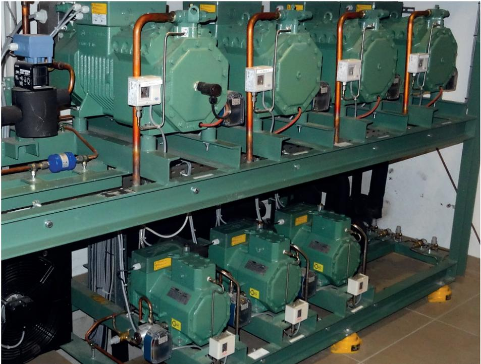
*Abb. Blick auf ein Kälteverbundsystem mit Hubkolbenverdichter*
