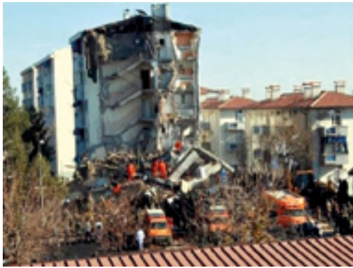
Schäden durch Kesselexplosionen (ORF Steiermark, 2012; FF Pinkafeld, 1996)
