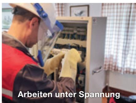
Arbeiten unter Spannung
