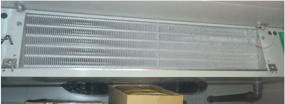
Abb. Blick auf Verdampfer in einer Kühlzelle
