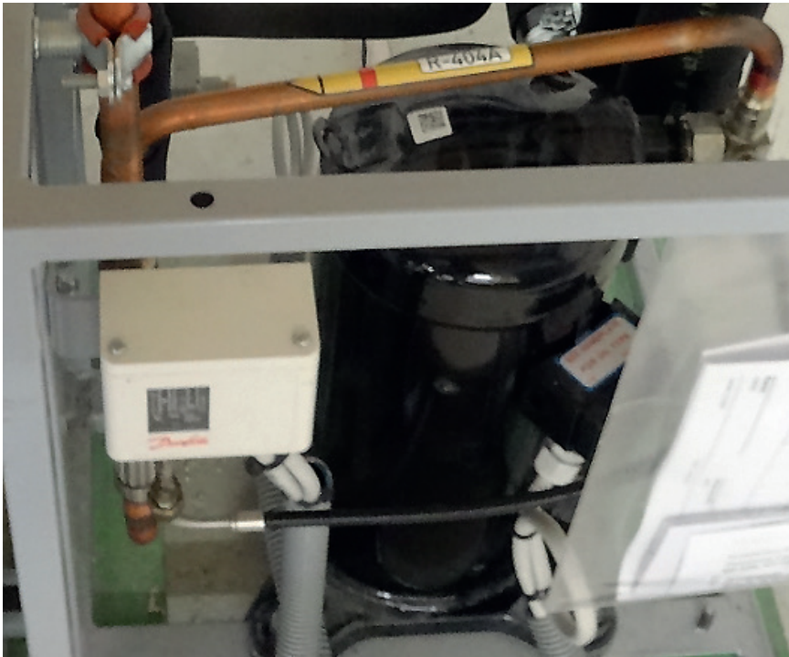
Abb. Blick auf einen Scrollverdichter
