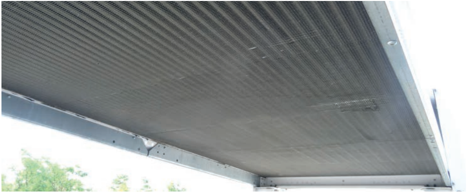
Abb. Blick auf die Lamellen – Unterseite eines Kondensators
